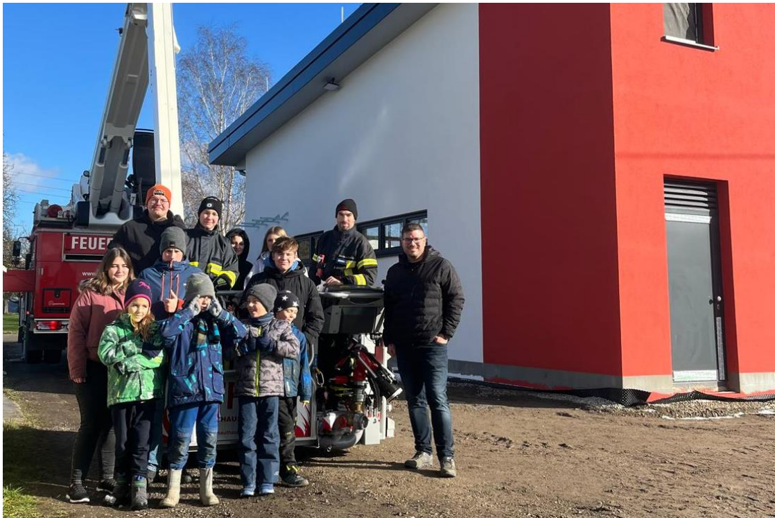
Und auch beim neuen Feuerwehrhaus halfen wir fleißig mit!
