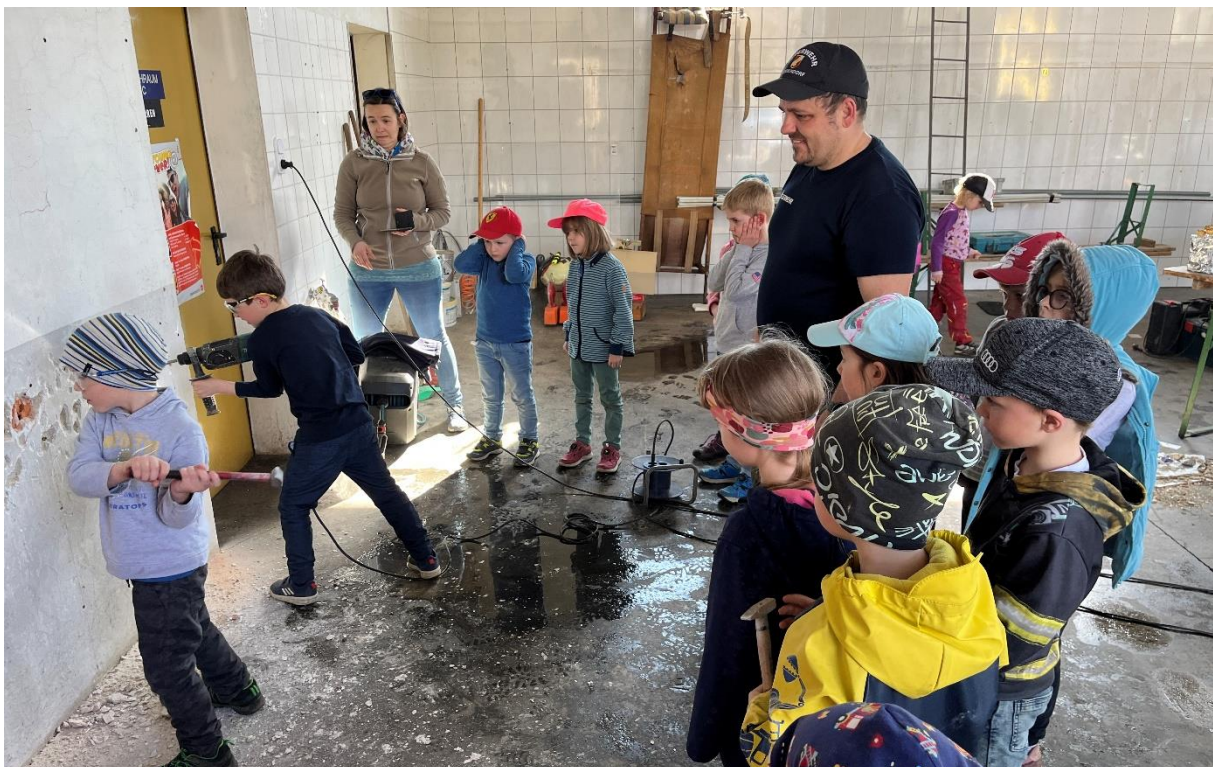
Jeder half beim Abriss des alten Feuerwehrhauses mit
