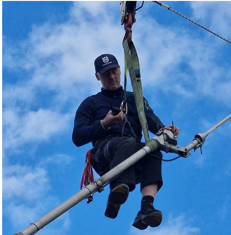
Der Ausbau des alten Funkmastes brachte unsere Kameraden zu Höchstleistungen
